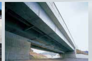
▲ 山陽自動車道大沢高架橋
