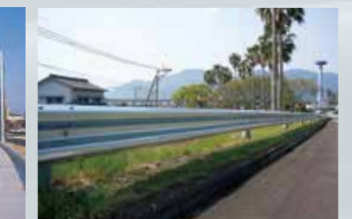
▲九州自動車道桜島SAガードレールビーム(再生亜鉛めっき)
