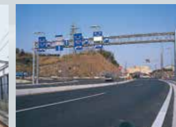
▲標識柱(今治IC付近)
