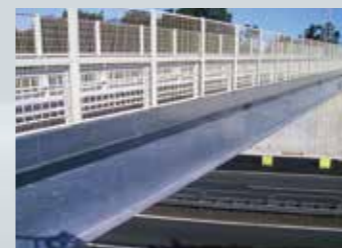
▲山陽自動車道大沢高架橋
